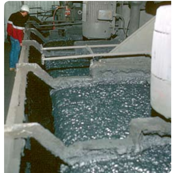
Des cellules de flottation sont utilisées dans le processus de traitement. (Photo : Gouvernement du Yukon)
