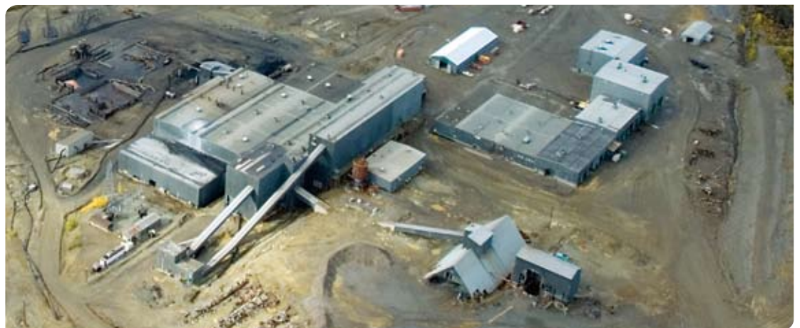
L'usine de traitement au complexe minier Faro. (Photo : Gouvernement du Yukon / Archbould Photography)
