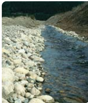
1. Dérivation du ruisseau Faro.
