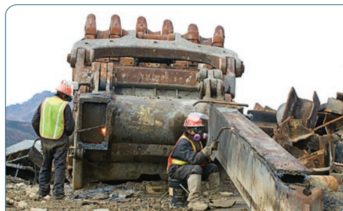
Des employés du CDRR découpent en ferraille des pièces de machinerie abandonnées de métal en vue de leur enlèvement du complexe minier de Faro.
