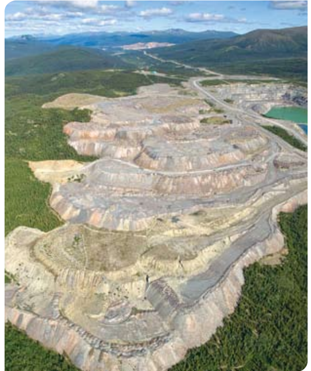
Zone Grum du complexe minier Faro. C'est dans cette zone que sera mis en oeuvre le projet de la zone sulfurée Grum. Les travaux permettront de refaire la pente de l'amas de stériles et d'installer une membrane et une couverture ultra résistante. Photo : Gouvernement du Yukon/ Peter Mather
